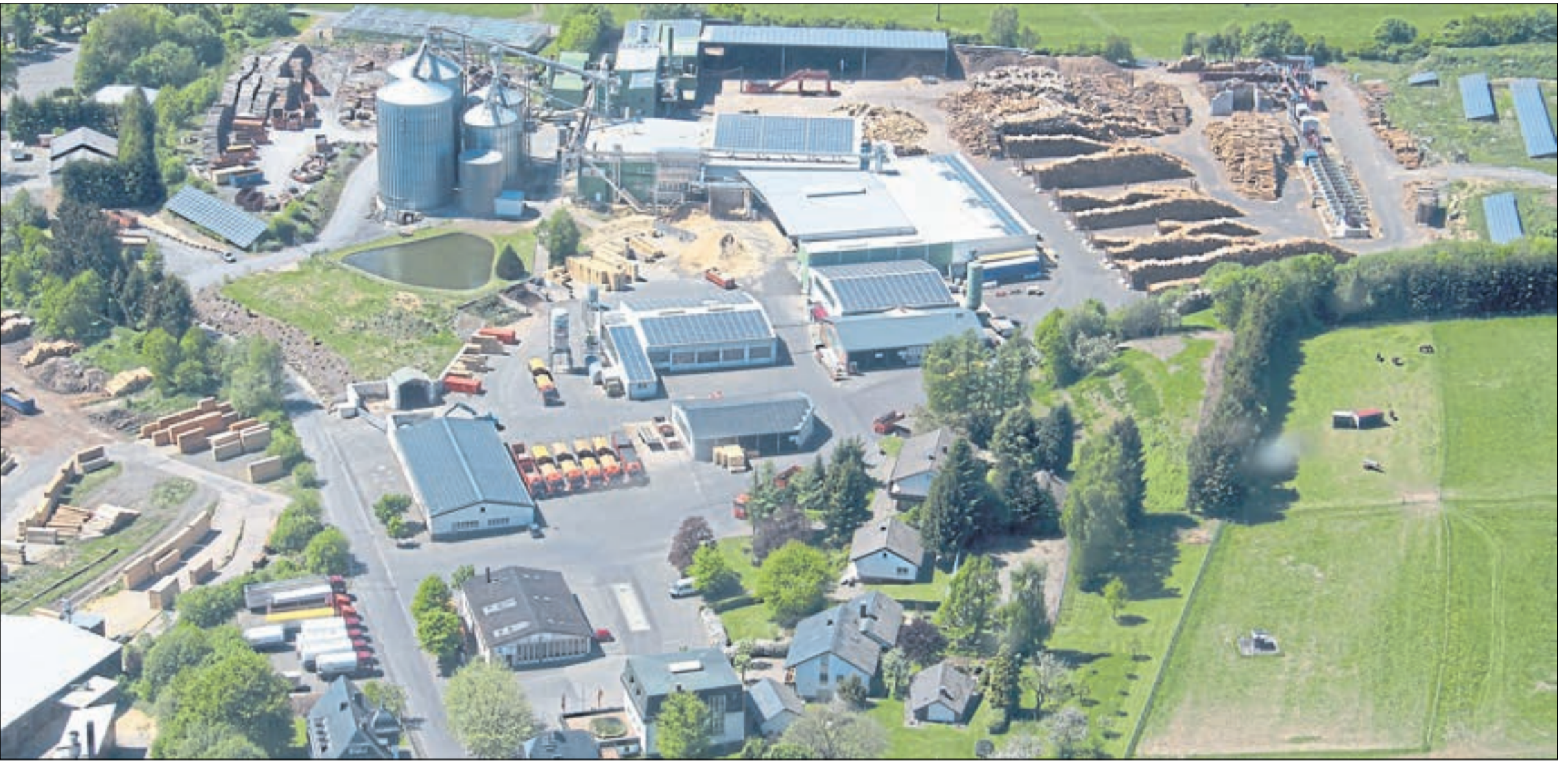
Best Practice: Die Westerwälder Holzpellets GmbH aus Langenbach vermeidet Lastspitzen durch aktives Lastmanagement – und spart damit potenziell Energiekosten von mehr als 10 000 Euro pro Jahr.
